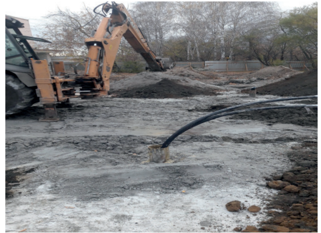
Рис. 4. Обустройство геотермических скважин теплообменными зондами (трубы зонда выведены из устья ближней скважины). Фото предоставлено компанией ООО Эс Би Джи (SBG Ltd)
