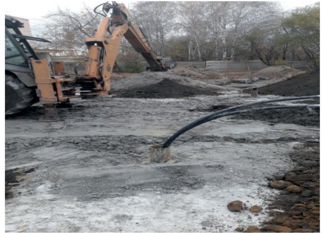
**Рис. 4.** Обустройство геотермических скважин теплообменными зондами (трубы зонда выведены из устья ближней скважины). Фото предоставлено компанией ООО Эс Би Джи (SBG Ltd)
