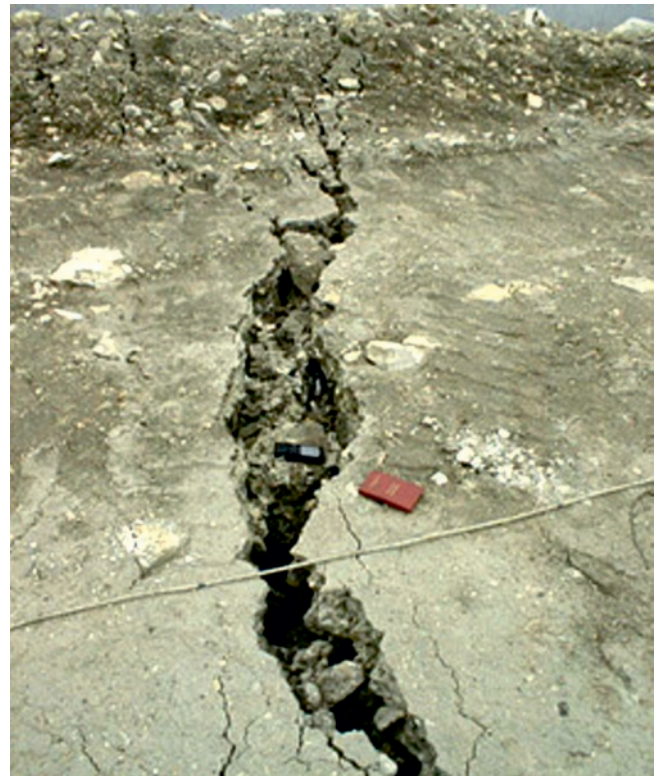
Рис. 2. Морозобойная трещина на дороге. Фото С. И. Серикова
